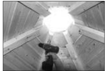
Dachhaube von innen mit Schrauben befestigen
