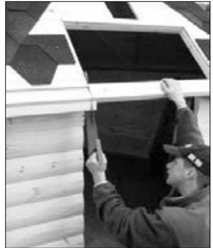
Vorgang Trennschnitt durch die Dachtraverse. Linie gleich Schnittpunkt und Schnittrichtung!
