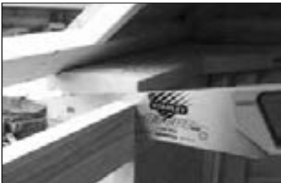
Zuletzt wird die Dachplattenauflage wie abgebildet ausgeschnitten (Markierung)
