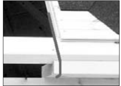
Vorgang Trennschnitt durch die Dachtraverse. Linie gleich Schnittpunkt und Schnittrichtung!
