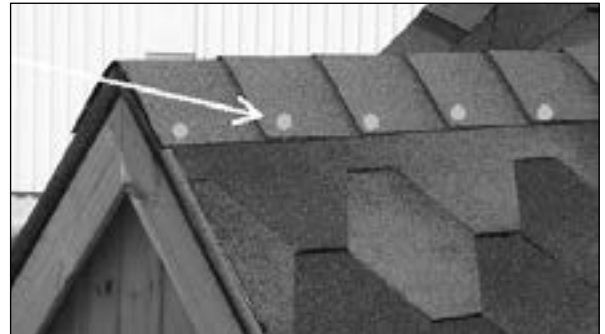
Schindel mit Dachpappennägel befestigen
